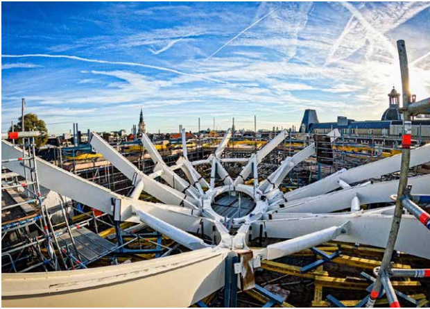
^ Opbouw kap op locatie vanuit het oog en de trechter. (Foto: BINX Smartility)
